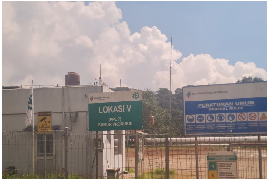
Contoh bangunan untuk pekerjaan pemeliharaan & pengecatan.
